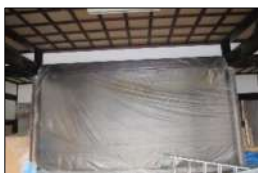
本堂内 (大間) 工事作業
