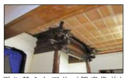
張り替えた天井 (観音像前)
