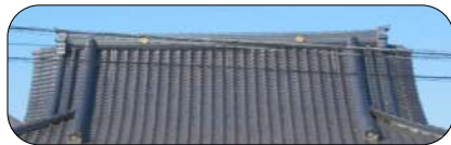
地震修復後の棟瓦 (若干低くなっています)
