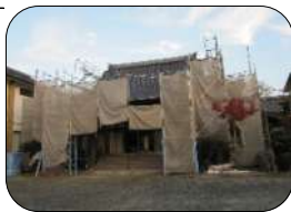
屋根工事に用いた足場
